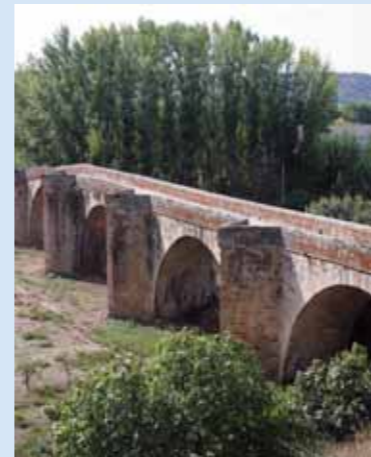
Puente Viejo o "Puente sin río"
