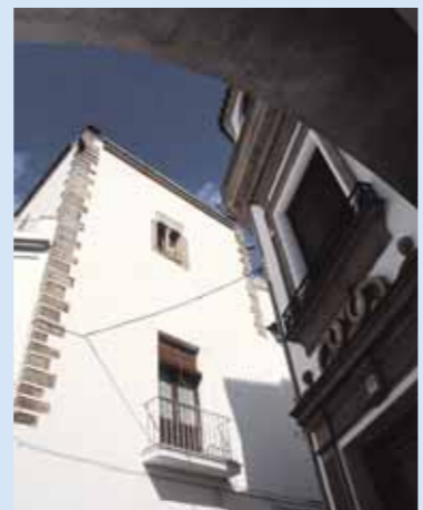
Palacio del Bachiller Juan M. de Logroño
