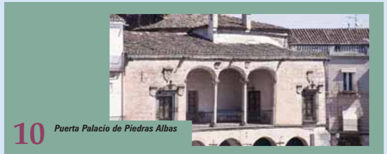
10 Puerta Palacio de Piedras Albas
